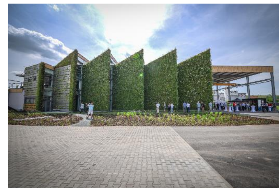
Zelené fasády a střechy
